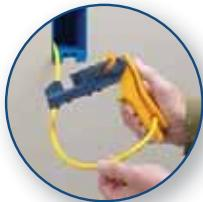
1. Удалите изоляцию кабеля с помощью стандартного или встроенного инструмента для зачистки кабеля.
