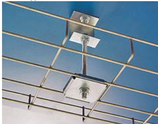
На подвесе "шпилька+ПППЛ и КППЛС"
